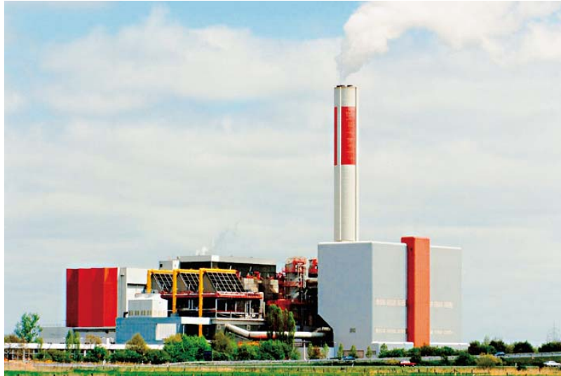
Müllheizkraftwerk der BEG. Foto BEG
