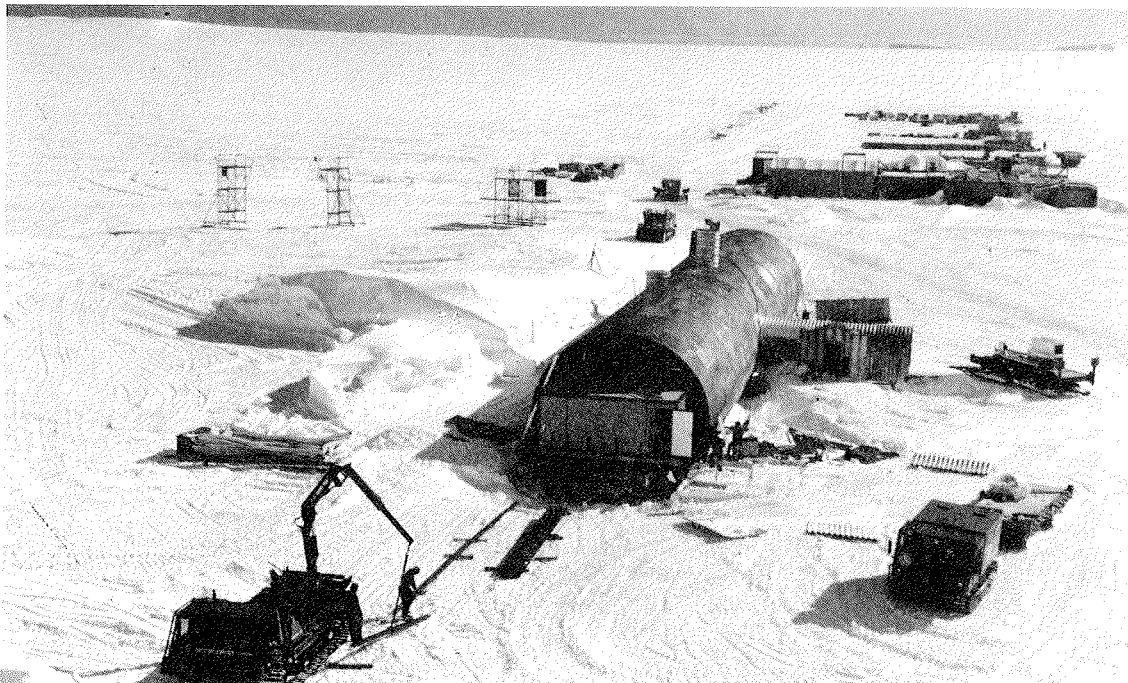
Die Georg-von-Neumayer-Station: Aufbau der ersten Röhre
