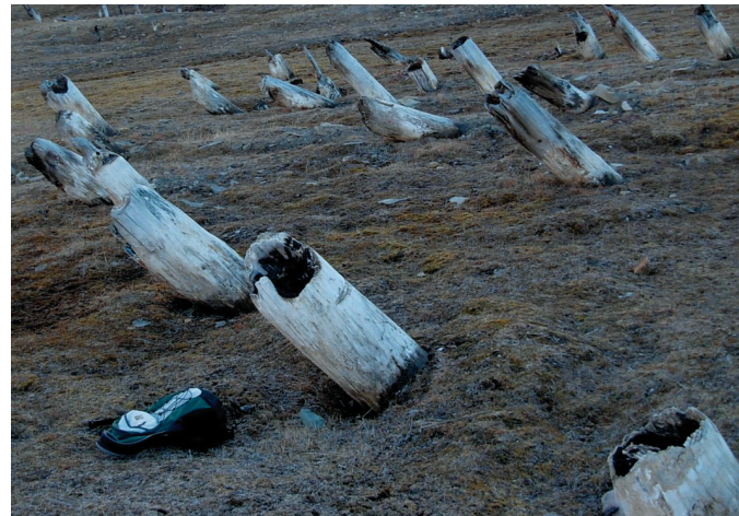
Abb. 2: Von Solifluktionprozessen geneigte Holzfundamente im alten Ortskern von Longyearbyen (Foto: Oliver Wild, Juni 2010).
