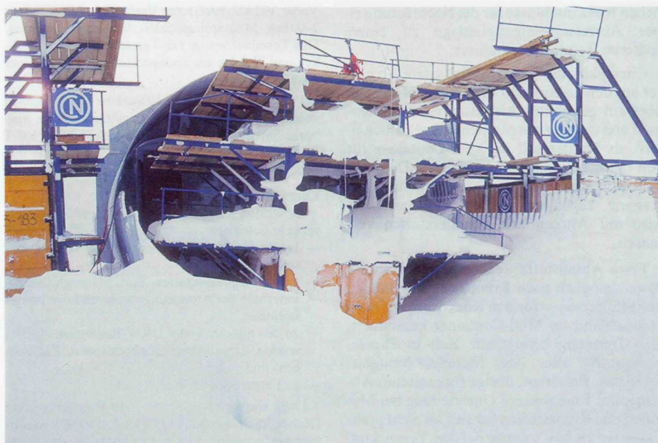
Schneeverwehungen an der Baustelle
