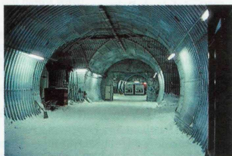
Querröhre mit verstärkten Kreuzungsbereichen
