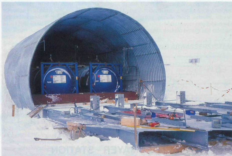
Einbau der Tankcontainer
