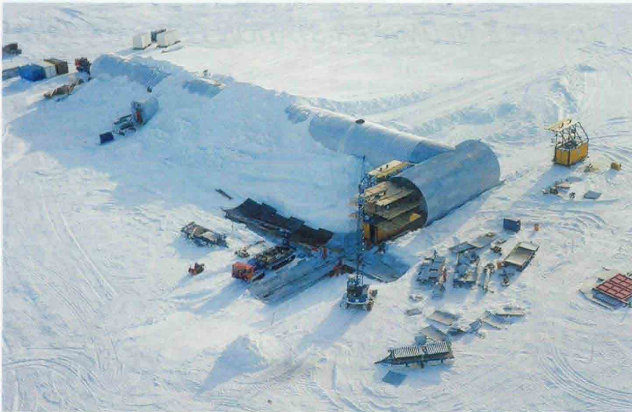
Die Weströhre wird angeschüttet
