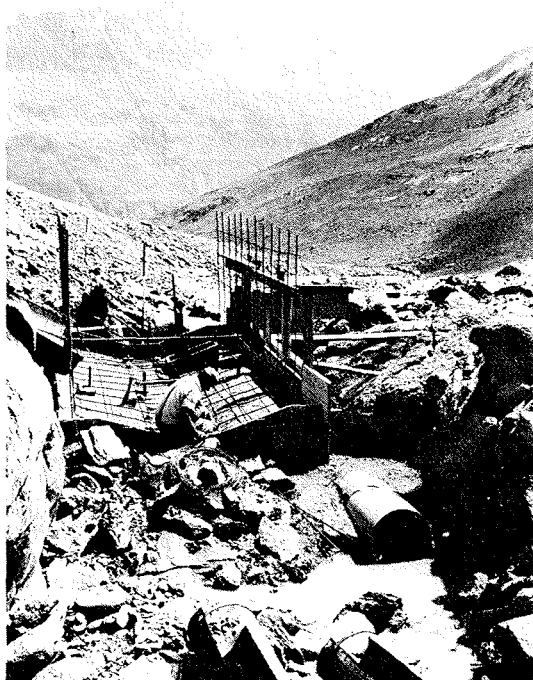
Abb. 4: Die Baustelle am Vernagt-bach im Sommer 1973: Die Fundierung der Meßrinne ist betoniert. Der Ableitung des Restwassers dient die Umlaufleitung, welche nach der Fertigstellung ein Trockenlegen der Rinne ermöglicht. In der Meßrinne ist die Schalung für den Meßschacht sichtbar.
