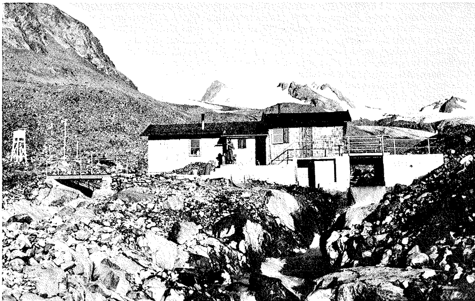
Abb. 5: Ansicht der Pegelstation Vernagtbach nach deren endgültiger Fertigstellung. Der im Bild links erkennbare Anbau mit Aufenthaltsraum und Materialdepot wurde im Sommer 1975 erstellt. (Aufnahme O. Reinwarth)
