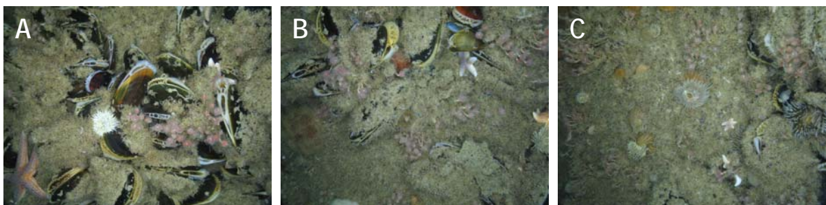
Abb. 2.4.16: Bedeckung der Unterwasserkonstruktion von FINO 1 im Herbst 2007 in (A) 5,0 m, (B) 5,2 m und (C) 5,6 m Wassertiefe.
