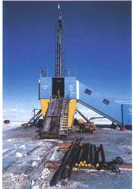
Abb. 6: Etwa 15 Kilometer vor dem Cape Roberts / Antarktis wurde auf nur 1,5 bis 2 Meter dickem Meereis ein 25 Tonnen schwerer Bohrturm aufgebaut. Mehr als 1,3 Kilometer Bohrgestänge kamen zum Einsatz, um bei einer Wassertiefe von 295 Metern Gesteinskerne von einer Länge bis zu 940 Metern aus dem Untergrund des Rossmeer-Schelfes zu bohren. (Foto: Niessen)
