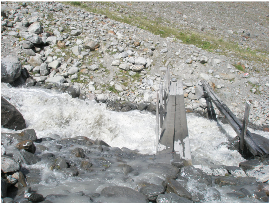
Abbildung 5: Brücke über den Bach des Kesselwandfernners am 07.08.2008.
