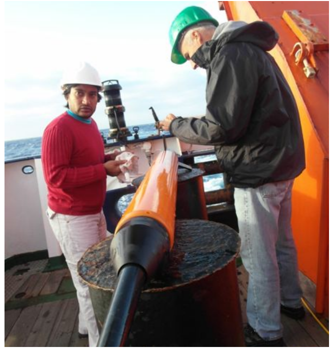
Begutachtung des durch Haifischbisse verursachten Schadens.
