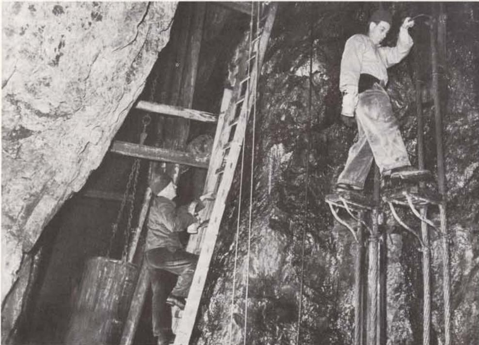
**Bild 4:** Bei der Fahrkunst wechselt der Bergmann nach jedem Hub das Podest — hier am Drahtseil — und gelangt nach über- oder untertage
