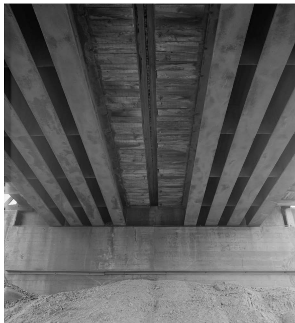
Abb. 1: I-Träger unter einer Brücke (De Vries, David G., 2007)
