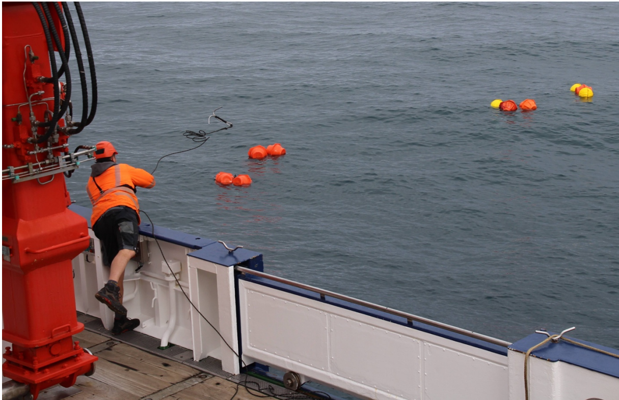
Abb. 2: Bei der Bergung einer Verankerung kommt ein Wurfhaken zum Einsatz (Foto: Dragonfly Leathrum-Simons).
