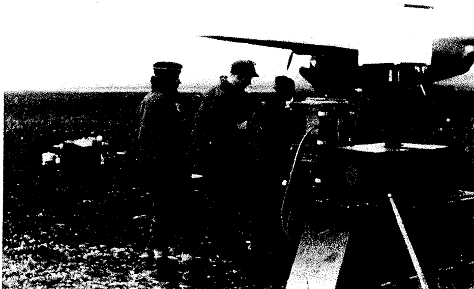
Abb. 9: Das automatische Wetter-Funkgerät „Kröte“ bei der Aufstellung auf der Edge-Insel, Spitzbergen am 4. August 1943.
