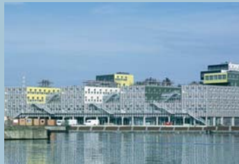
Zentrale des Alfred-Wegener-Instituts – Das Hauptgebäude in Bremerhaven Headquarter of the Alfred-Wegener-Institute – the main building in Bremerhaven
