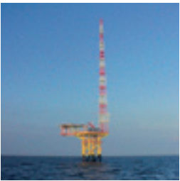
FINO Die Forschungsplattform FINO1 wurde im Herbst 2003 45 Kilometer nördlich von Borkum in 28 Meter tiefem Wasser in Betrieb genommen. Die Höhe des Windmessturms beträgt 100 Meter.
