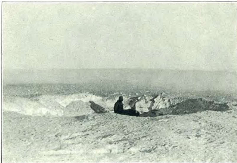
Sprengtrichter von 73 kg Trinitrotoluol in „Eismitte“. Seite 213.
