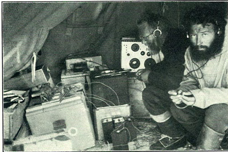
Aufnahme Keltl Weifen und Jülg bei der Schweremessung. Seite 238.
