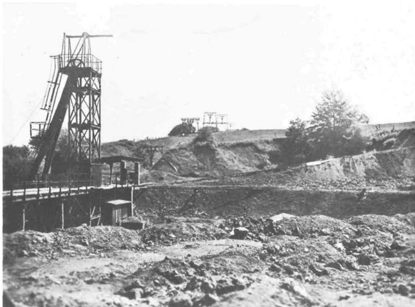
Abb. 3. Grube David (Christiansglück) mit Seilbahn, im Bau (1938).
