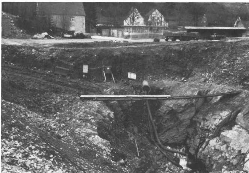
Abb. 6. Freilegung der Hillenberg-Quelle 2 durch Leerpumpen des Quellenteiches (fot. Dr. M. KOCH, 16. 4. 1977)
