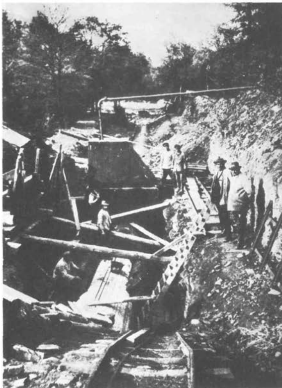
Abb. 8. Bau des Grundwasserstollens 1928/29 (fot. Lörmecke-Wasserwerk)
