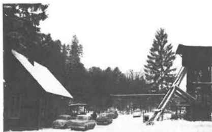
Abb. 22. Grube Dachsberg bei Nentershausen (1963). Das Lichtloch 17 des ehemaligen Kobaltbergbaus wurde zum Förderschacht umgebaut. Heute sind sämtliche Tagesanlagen verschwunden.
