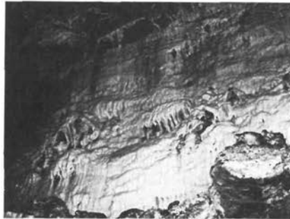
Abb. 23. Mit Kalksinter überzogene alte Baue in einem Stollen auf dem südlichen Nebengang des Herzberger Ganges. – Herzberg, Nordwesthang.
