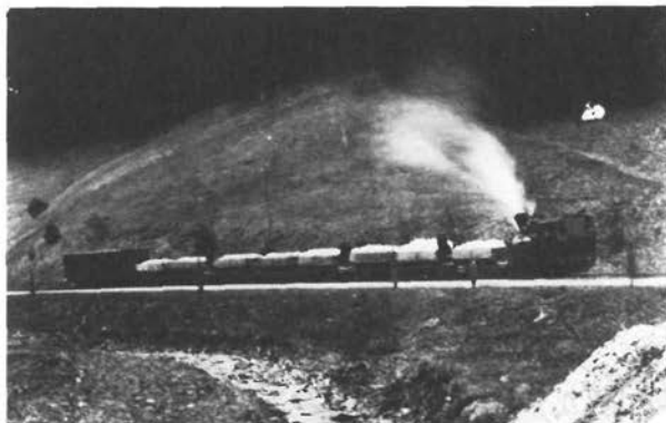
Abb. 13. Eine 10 km lange Schmalspurbahn verband die Grube Mündens und das Sontraer Schwerspatwerk. (Foto: Archiv Deutsche Baryt-Industrie).
