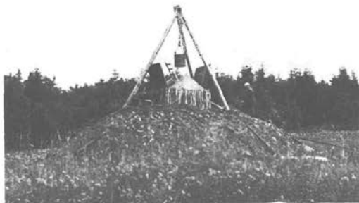
Abb. 3. Beginn des Abteufens des Versuchsschachts Anna bei Orferode (1965). Der Schacht erreichte bei 12 m bereits die Gangwurzel. Das nach wenigen Monaten Betriebszeit wieder aufgelassene Bergwerk hat lediglich 650 t Baryt geliefert.
