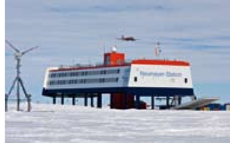
Als erste Forschungsstation in der Antarktis ist die Neumayer-Station III ein kombiniertes Gebäude für Forschung, Betrieb und Wohnen auf einer Plattform oberhalb der Schneeoberfläche, verbunden mit einer in den Schnee gebauten Garage. Mit Neumayer III werden insbesondere die Beobachtungen der beiden vorhergehenden, inzwischen im Schnee versunkenen und aufgegebenen Stationen fortgesetzt, mit denen seit 1982 wichtige Veränderungen der antarktischen Atmosphäre untersucht werden ( http://www.awi.de/de/infrastruktur/stationen/neumayer_station/ ). (Foto: realnature.tv)
