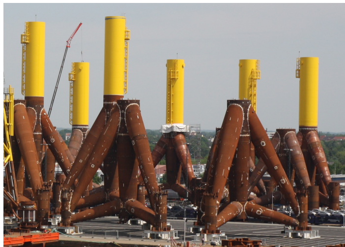
Abb. 7.2: Tripod-Fundamente auf der ABC-Halbinsel in Bremerhaven
