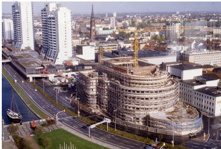
Die Baustelle des Ungers-Baus, des heutigen Wegener-Gebäudes (Gebäude D)
