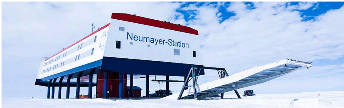
Der dritte Neubau der Neumayer-Station wurde an der Oberfläche erbaut.
