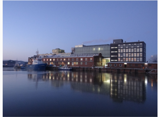
Abbildung 10: AWI-Hauptgebäude in Bremerhaven [AWI19]
